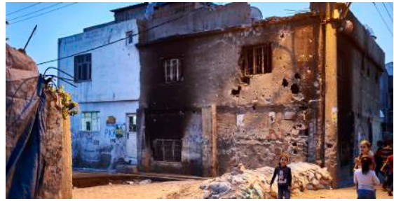
Augenschein im Nur-Quartier: ausgebranntes Wohnhaus mit sichtbaren Einschlaglöchern
