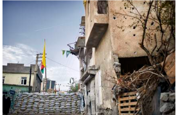
Augenschein im Nur-Quartier: nachträglich errichtete Strassensperre neben zerschossenem Wohnhaus
